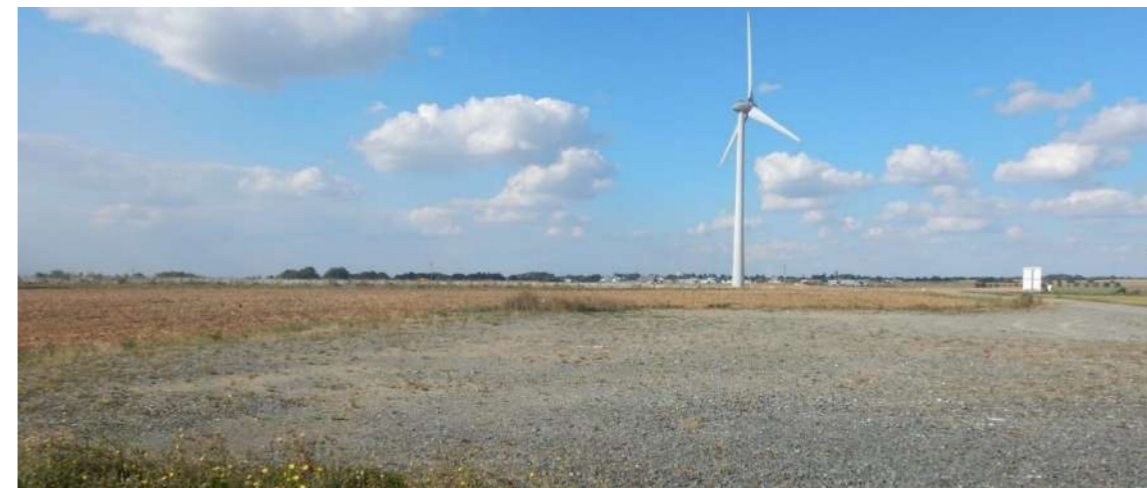
Photo 180 : un exemple d'aire de grutage depuis le pied d'une éolienne
