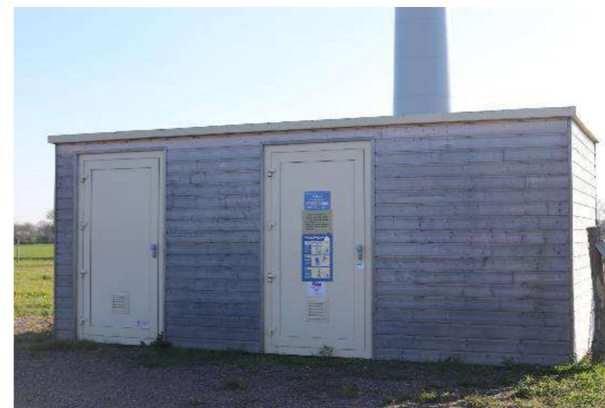
Photo 182 Exemple de poste de livraison
