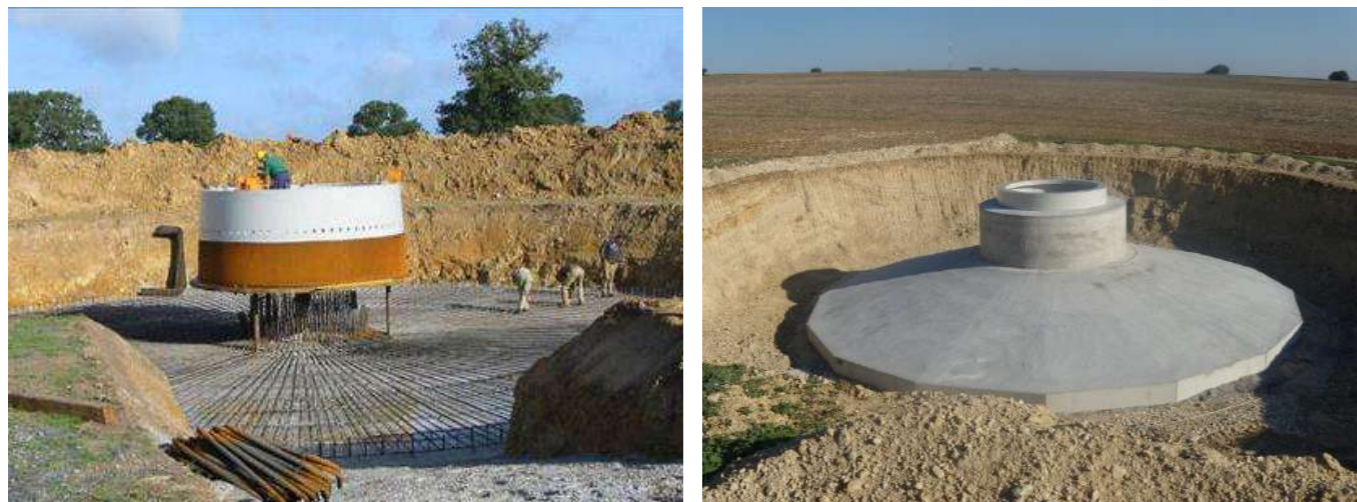
Photo 179 : Le coulage d'une fondation d'éolienne
